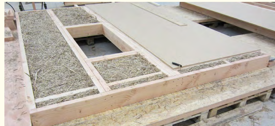
Figura 48 Proceso de fabricación de una pared de estructura de madera rellena con una capa de carrizo [REF 32].
