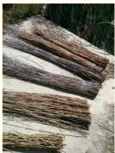
Figura 19 Preparación de los fardos de carrizo en PIPA.
