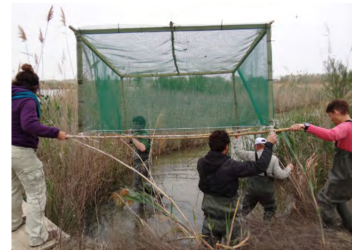
Figura 43 Arriba y abajo Construcción y colocación de cercados para la protección de vegetación sumergida.
