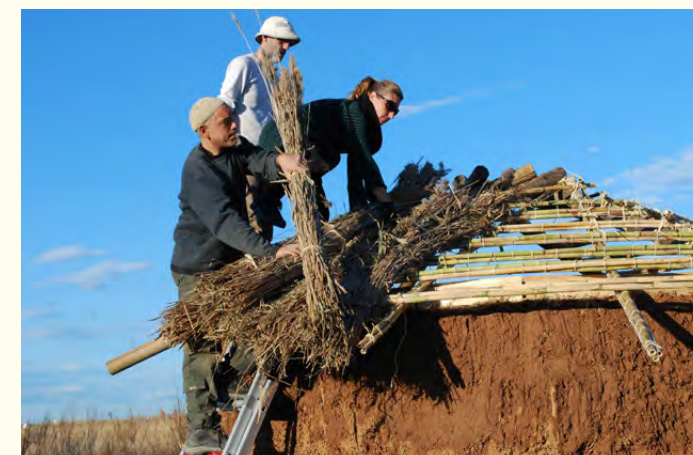
vegetales, utilizar el carrizo de PIPA para cubrir el techo de la casa de paja.
