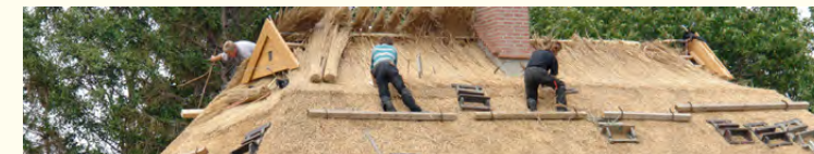
Figura 45 Construcción artesanal de una cubierta de carrizo[29].
