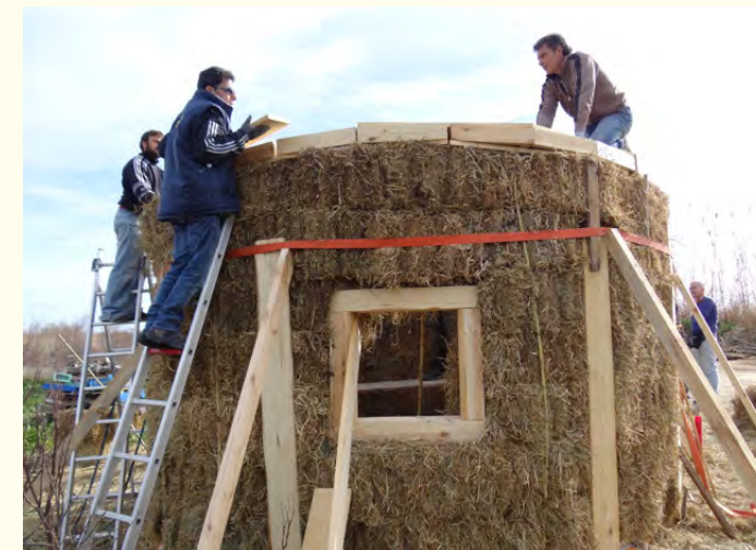
Figura 38 Montaje de los muros autoportantes con balas de paja de arroz.
