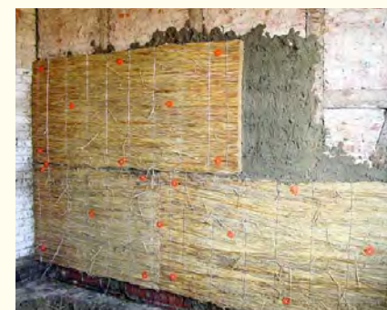
Figura 49 Ejemplo del uso de paneles de carrizo ordenado como capa de aislante en una pared de piedra. [REF 30].
