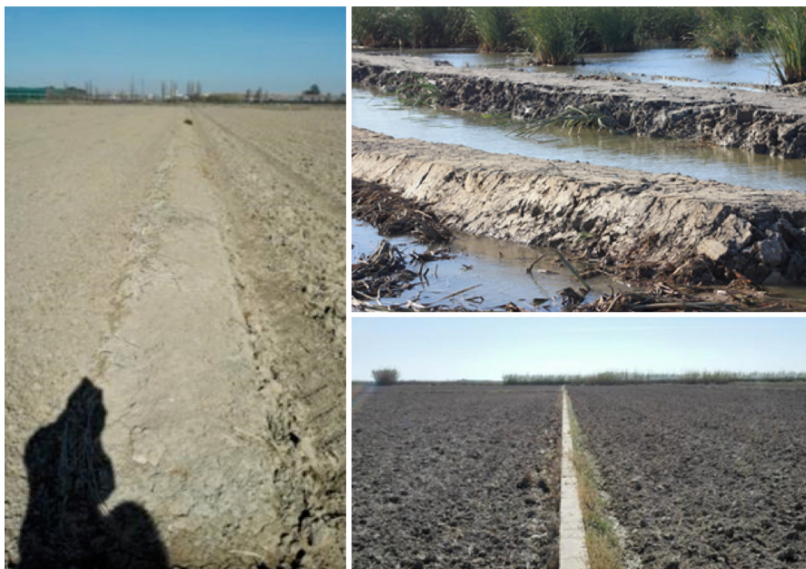
Figura 13 Imágenes de motas de tierra (izda. y dcha. arriba) y hormigón (dcha. abajo).
