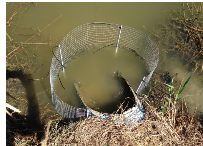
Figura 28 Imagen de rejilla de protección aguas arriba de un conducto enterrado.
