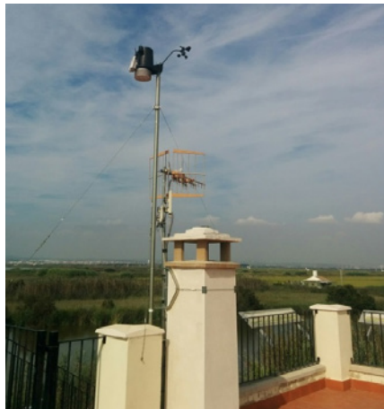
Figura 47 Estación meteorológica instalada en el HA del tancat de la Pipa.
