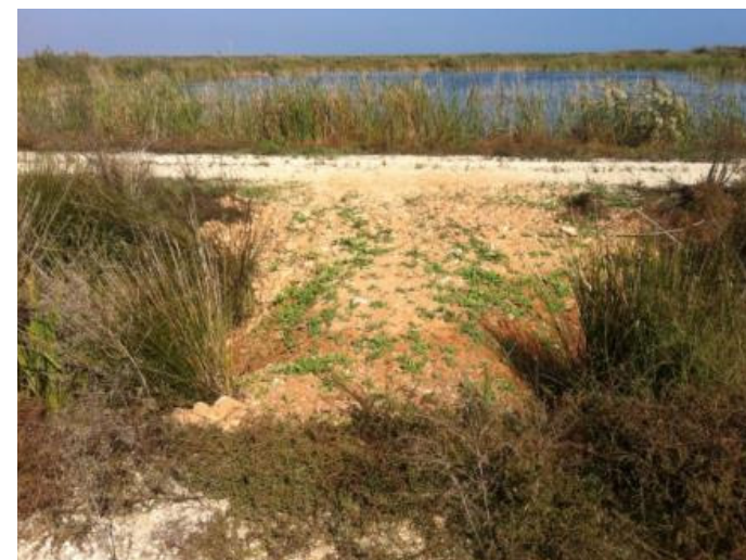
Figura 16 Terraplenes de separación de celdas en HATM y HATLI.
