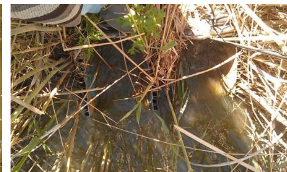
Figura 26 Imágenes de la salida de tubos sumergidos en los que se puede apreciar la acumulación de sedimentos.
