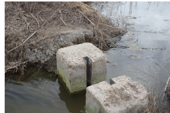
Figura 15 Imagen de compuerta de paso construida con bloques de hormigón sobre mota de tierra.
