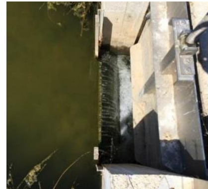
Figura 2.3. Esquema de conexiones en el Tancat de Milia y fotografía de flujo a través del vertedero, aguas arriba de la compuerta y tubo de conexión
