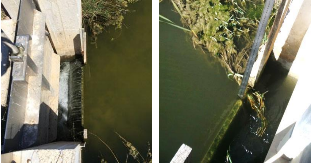
Figura 4.12. Vertederos situados aguas arriba de P4 (izquierda) y P6 (derecha)
