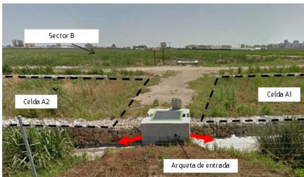
Figura 5.1. Arqueta de entrada por bombeo al sector subsuperficial (Sector A)
